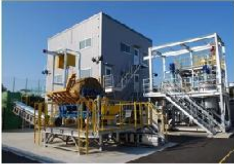
稲わらなどからバイオ燃料を造る実証施設
